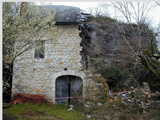
Chute de blocs Larroque Toirac - février 1985
