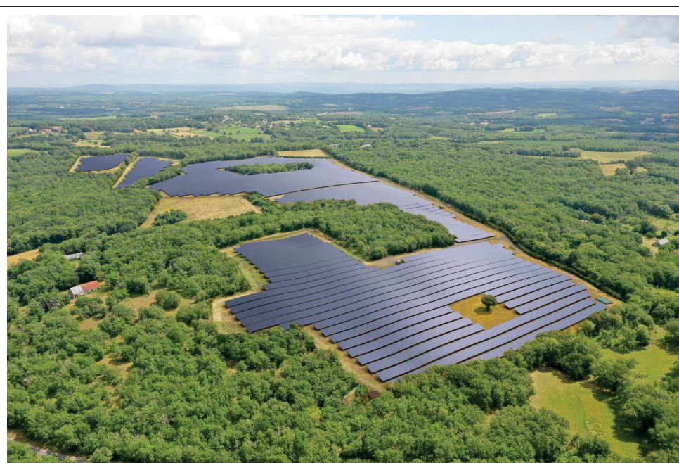
1 – Vue aérienne depuis l'angle Sud-Ouest du projet
