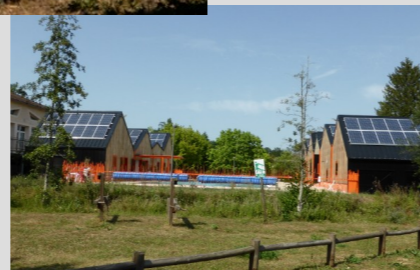
Panneaux photovoltaïques sur les bâtiments de la piscine de Salviac
