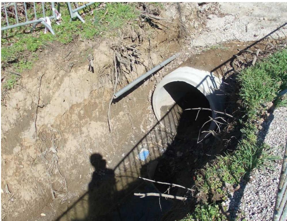
Photographies de l'exutoire des eaux pluviales de la partie Est du bourg de Puybrun
