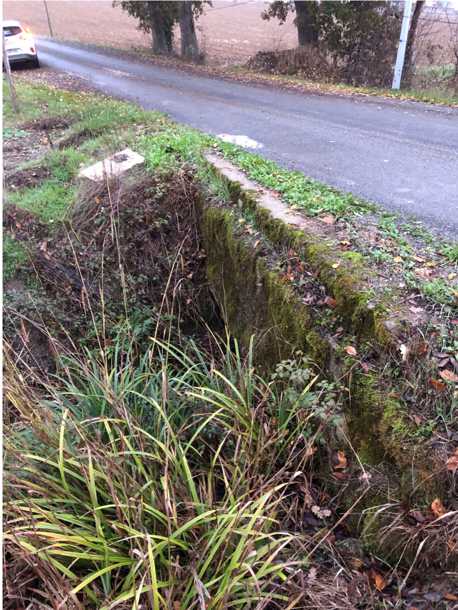
Vue Amont – photo prise en tête de berge Rive droite
