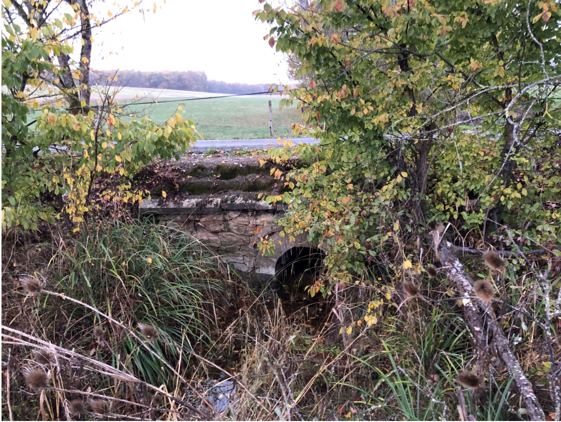
Vue Aval – depuis passage busé aval
