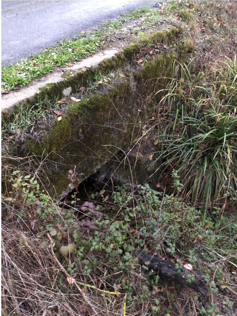
Vue Amont – photo prise en tête de berge Rive gauche
