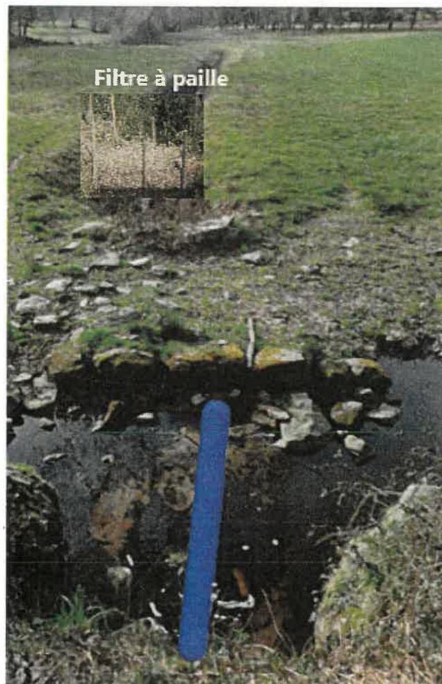
Un dispositif de filtre à paille et de géotextile disposé dans le fossé viendra bloquer les matières qui pourraient être en suspension.
