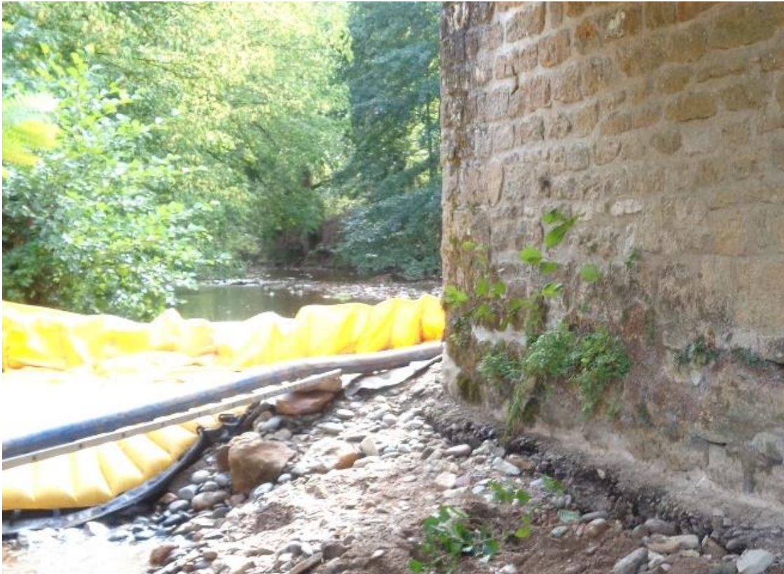
Batardeau type Watergate (travaux réseaux Pont de Granou – oct. 2019)
