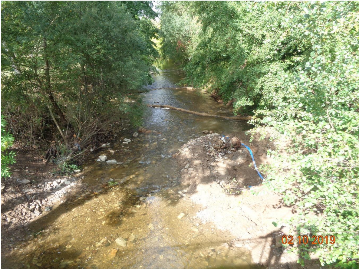
Filtre à paille (travaux réseaux Pont de Granou – oct. 2019)
