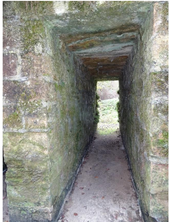
Vue de l'intrados de l'ouvrage
