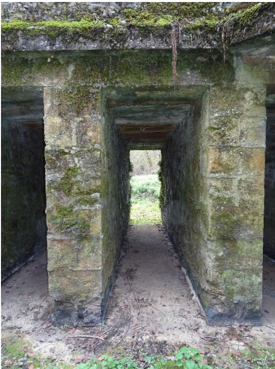
Vue de l'intrados de l'ouvrage
