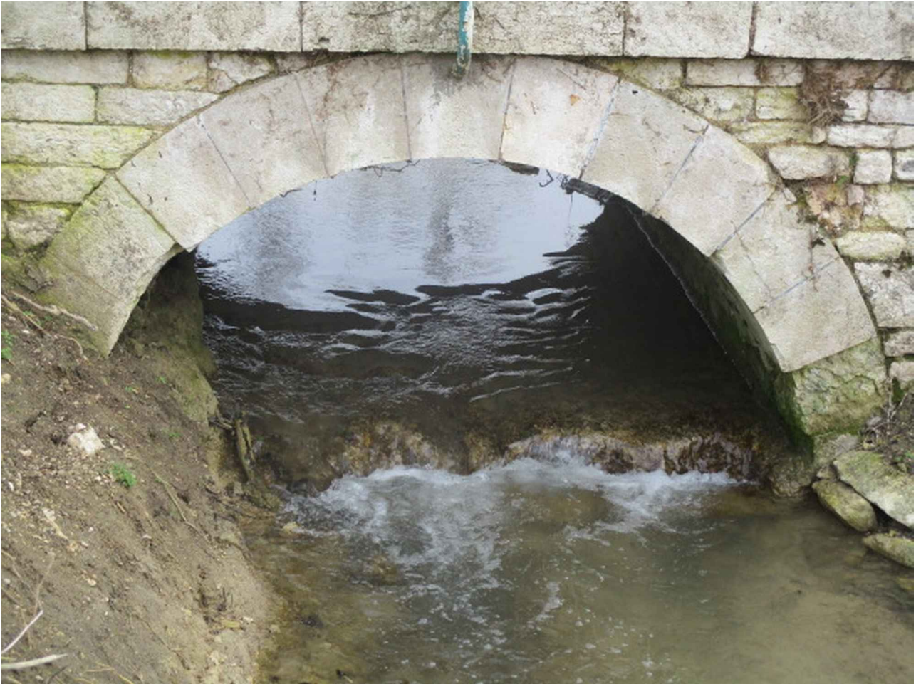
Vue du dépôt Calcaire sur la radier existant en aval du pont
