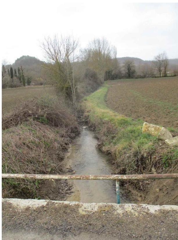
Vue du Ruisseau juste en aval du pont
