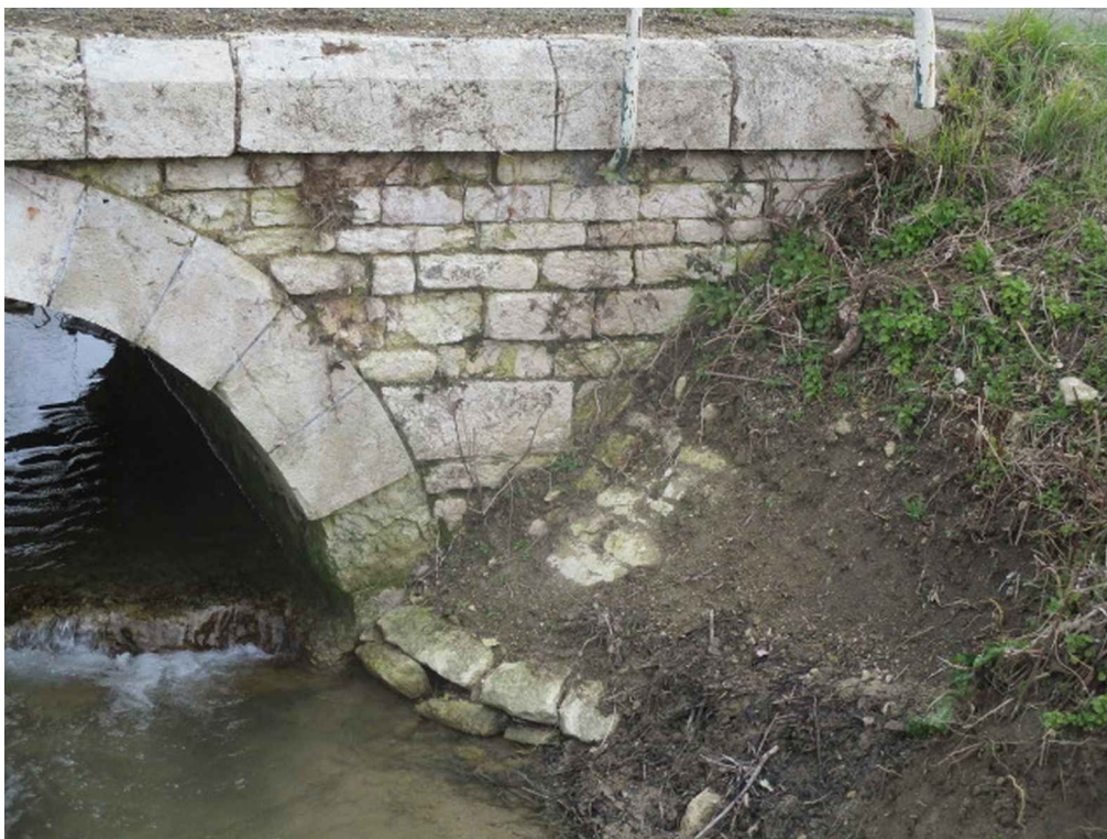
En aval du pont sur la Rive gauche, un enrochement de 1 m de large est visible
