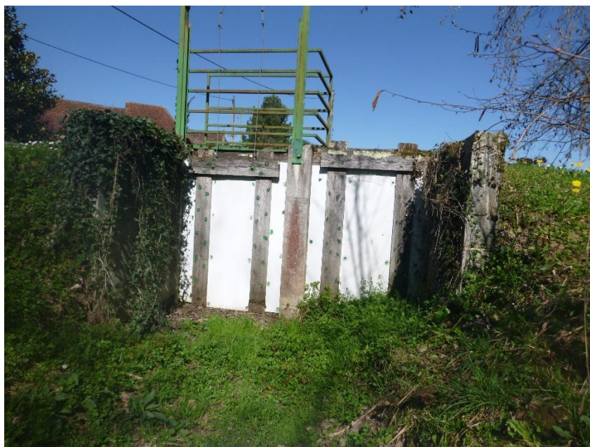
Figure 11 : Ouvrage manuel du fossé situé à l'ouest de l'école.
