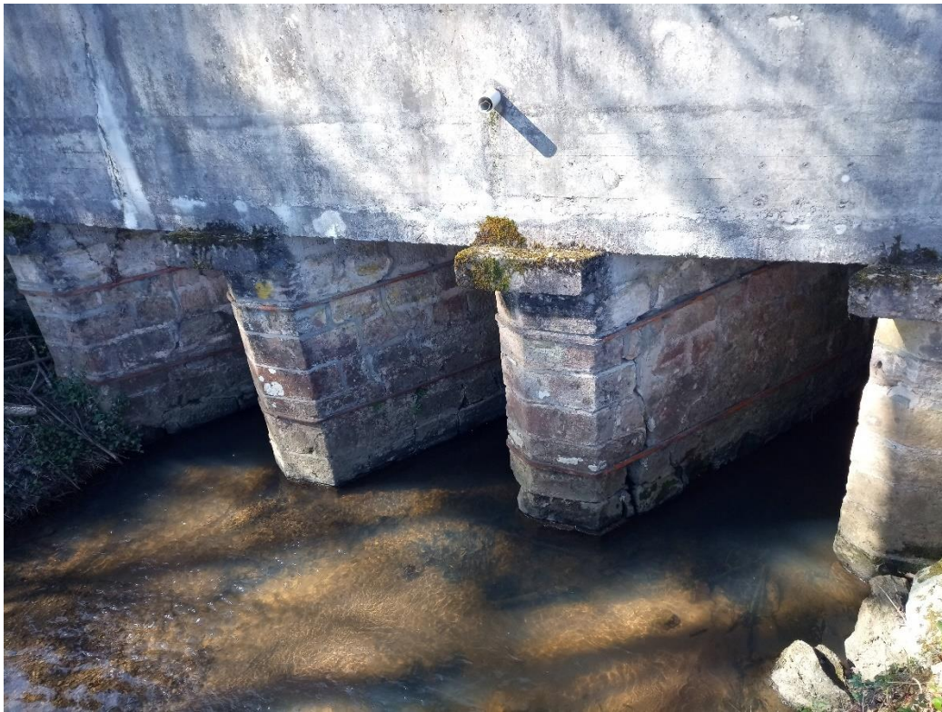
Photo 1 : Ouvrage de la RD 20
