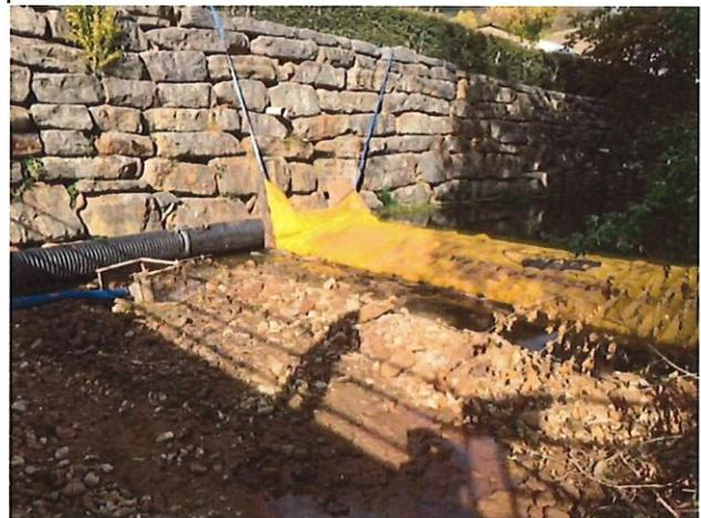
Dès terminaison de la pose de la canalisation d'eau potable, le busage du cours d'eau sera enlevé ainsi que le batardeau.
