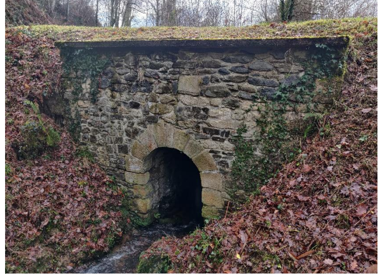
Vue de l'ouvrage depuis l'amont
