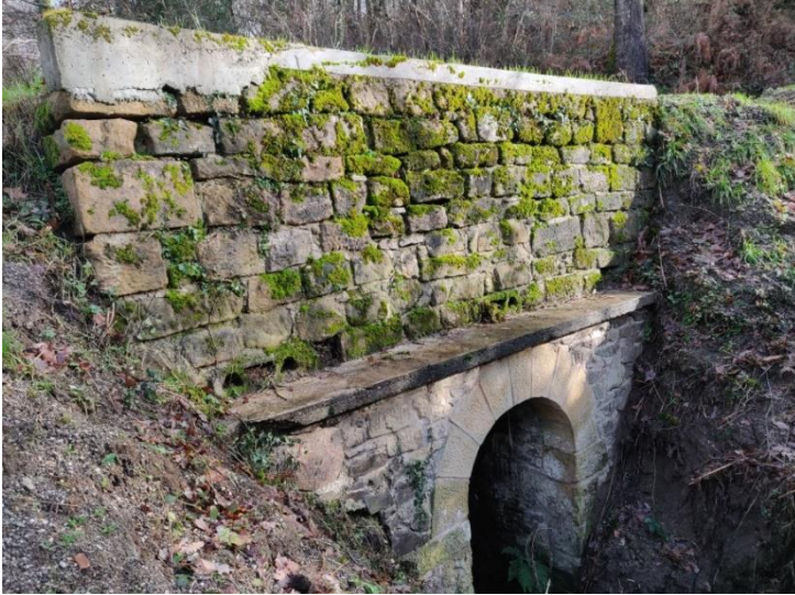
Vue de l'ouvrage depuis l'aval
