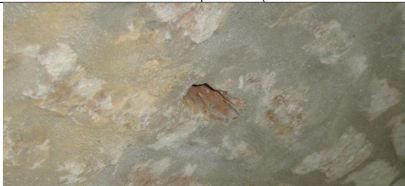
Exemple de réalisation sur un ouvrage restauré (Département 46).
