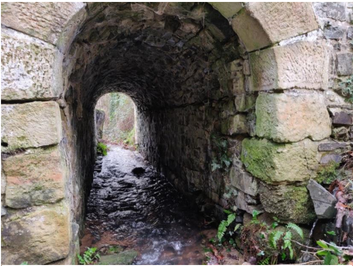
Vue de l'intrados de l'ouvrage
