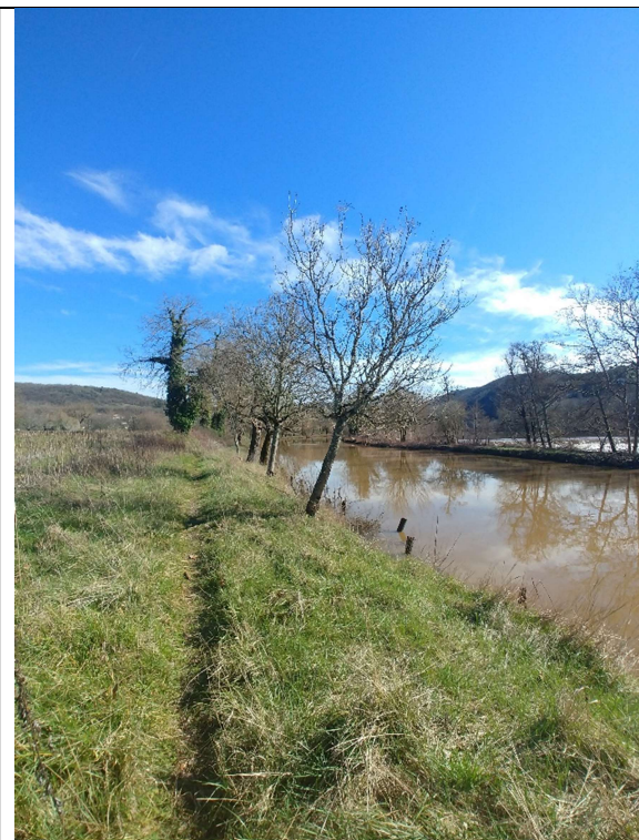
Impact sur ces arbres de faible envergure situés ici sur la zone nécessitant un enrochement.
