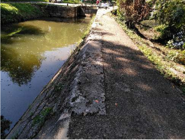
Photo 27 : Crête de la digue maçonnée en amont de l'écluse – Arcambal (BIEF).
