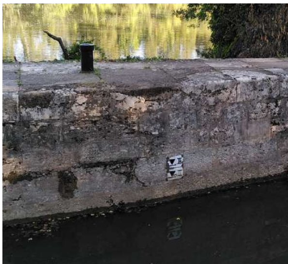
Photo 50 : Marques de crue sur l'écluse d'Arcambal (BIEF).
