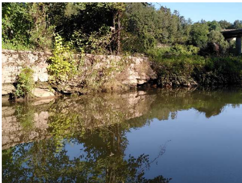
Photo 6 : Extrémité amont de la zone - Arcambal (BIEF).
