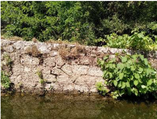
Photos 12 et 13 : Dégradations à la jonction entre le perré amont et le quai vertical au droit du moulin – Arcambal (BIEF).
