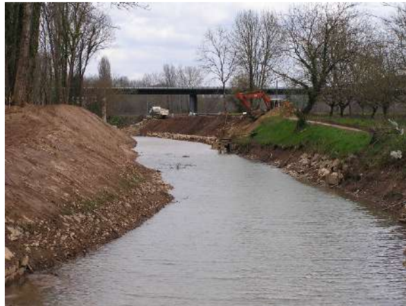
Photo 23 : Vue d'archive des travaux de retalutage des berges 2004 – Arcambal (Archive MOA).
