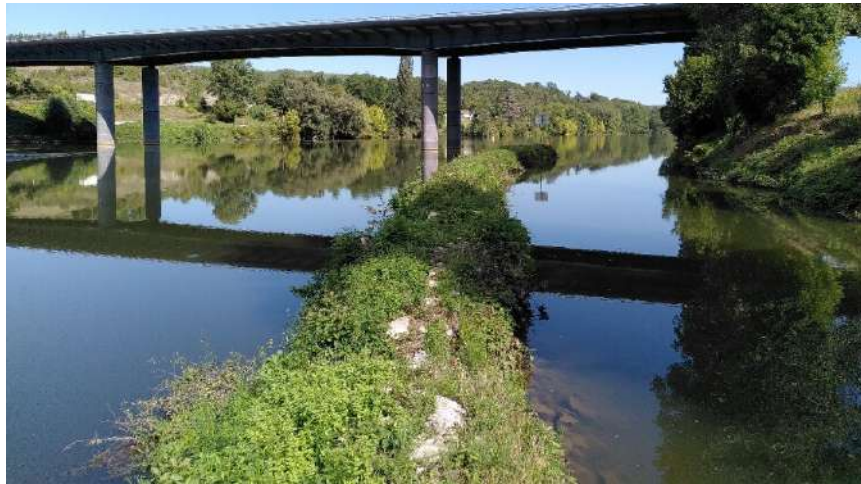
Photo 2 : Vue générale de la crête de la digue depuis l'aval- Arcambal (BIEF).
