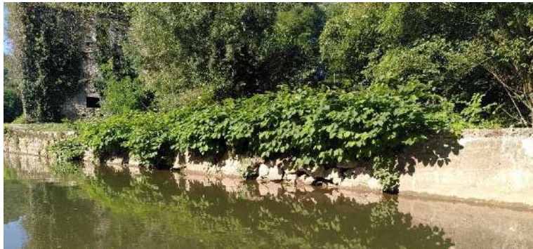
Photo 16 : Transition entre les deux tronçons - Arcambal (BIEF).
