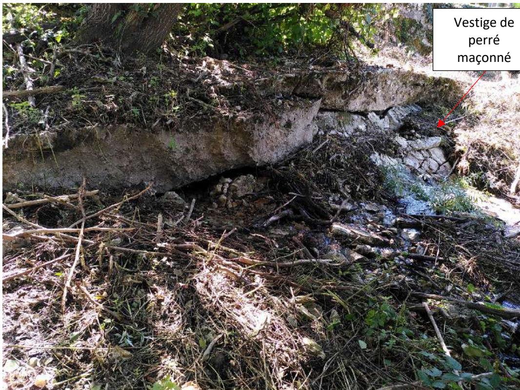
Photo 42 : Galette béton à l'arrière du guideau maçonné – Arcambal (BIEF).
