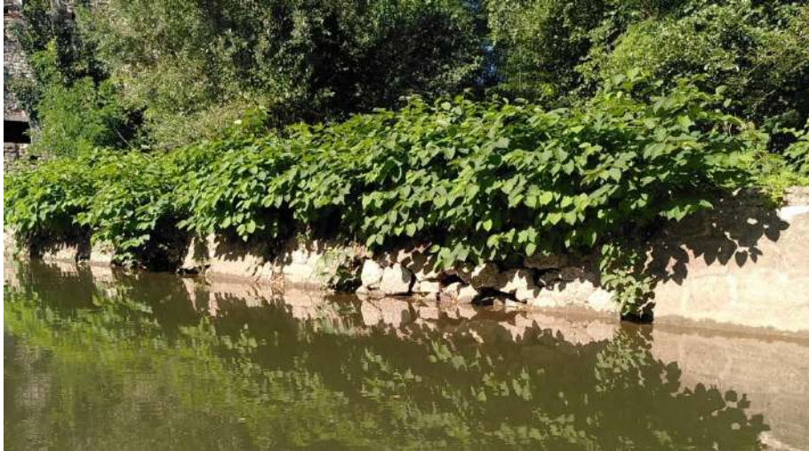
Photo 11 : Vue de la jonction avec le quai vertical au droit du moulin- Arcambal (BIEF).
