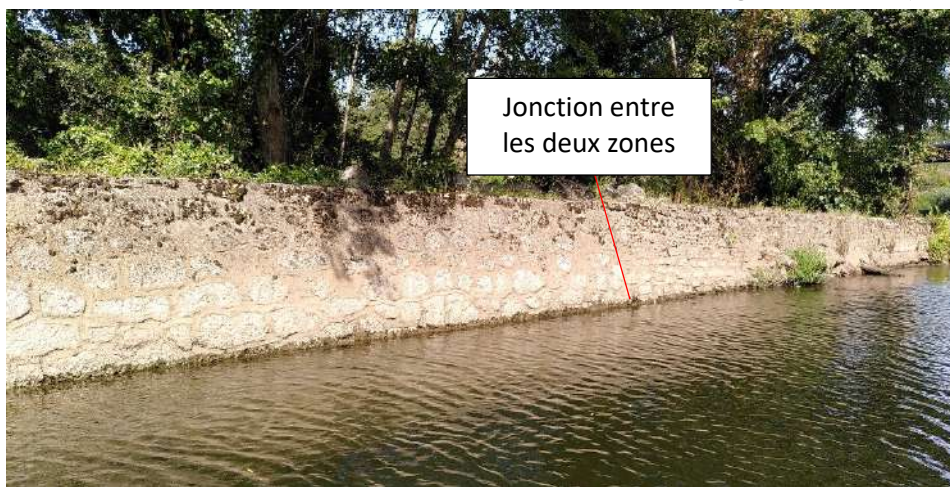
Photo 8 : Jonction entre les deux zones de la protection de berge – Arcambal (BIEF).
