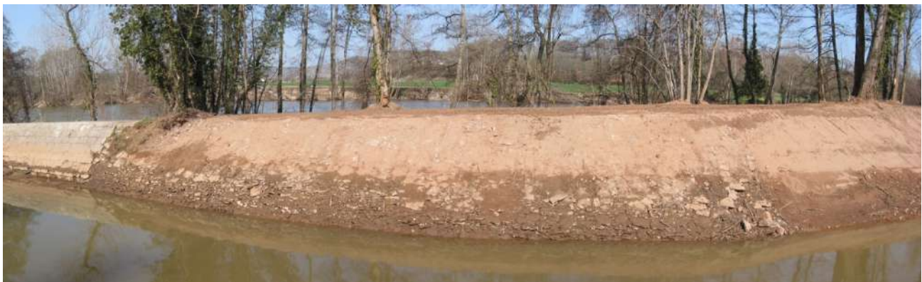
Photo 25 : Vue d'archive des travaux de retalutage des berges 2004 – Arcambal (Archive MOA).
