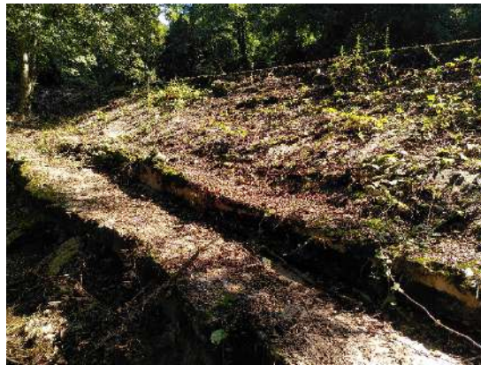
Photo 29 : Enrochement percolés côté Lot avec galette béton – Arcambal (BIEF).
