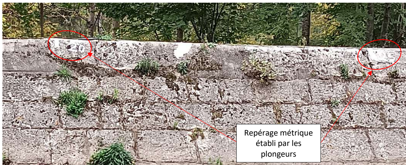
Photo 35 : Illustration du repérage métrique établi par les plongeurs- Arcambal (Archive MOA).
