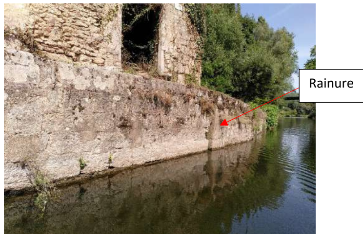
Photo 17 : Quai vertical au droit du moulin – Arcambal (BIEF).
