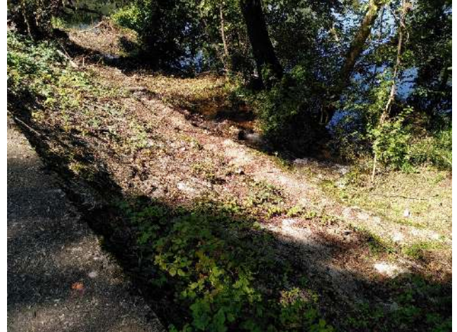
Photo 28 : Façade en enrochements percolés côté Lot – Arcambal (BIEF).
