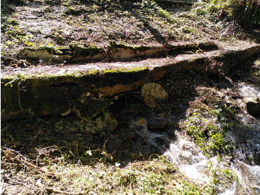
Photo 42 : Galette béton à l'arrière du guideau maçonné – Arcambal (BIEF).
