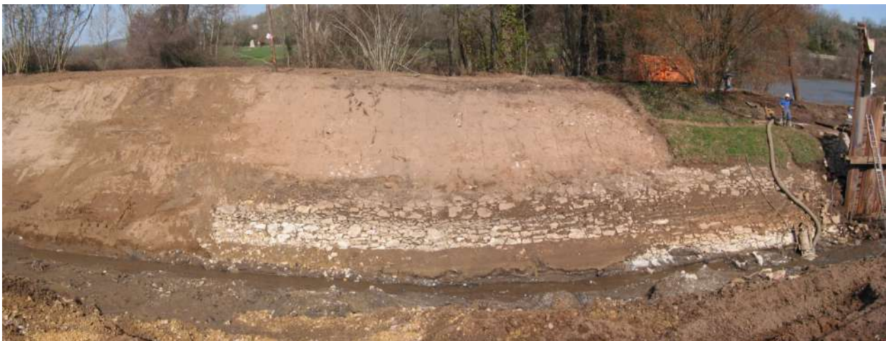
Photo 24 : Vue d'archive des travaux de retalutage des berges 2004 – Arcambal (Archive MOA).
