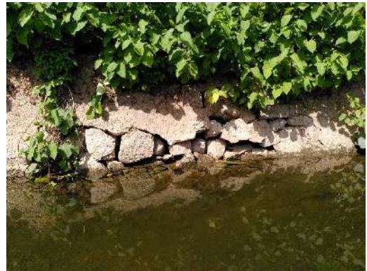
Photos 12 et 13 : Dégradations à la jonction entre le perré amont et le quai vertical au droit du moulin – Arcambal (BIEF).
