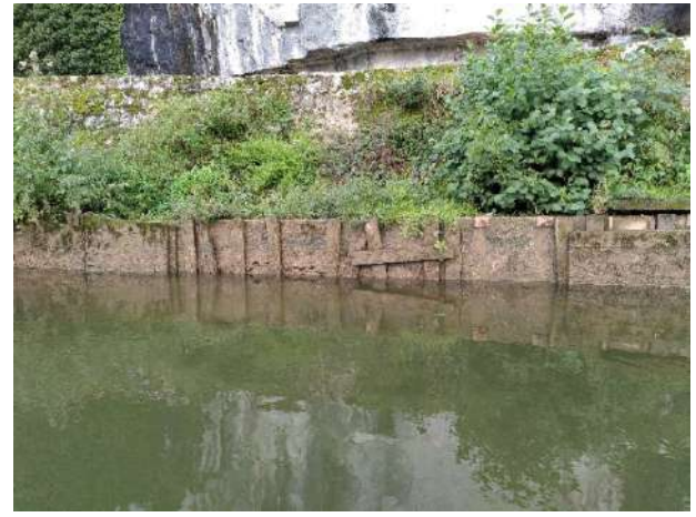
Photos 20 et 21 : Vues de la risberme côté Lot – plaques béton et palplanches – Ganil (BIEF).
