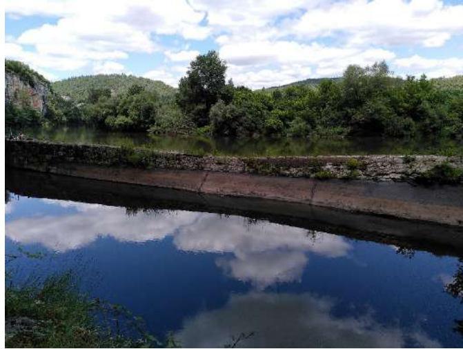
Photo 12 : Vue générale du guideau maçonné – Ganil (BIEF).
