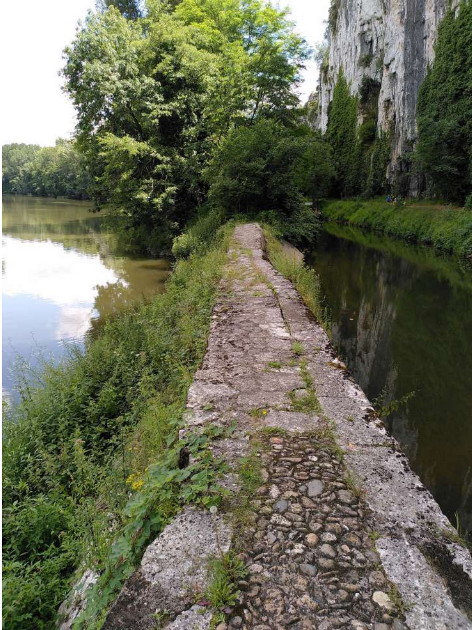
Photo 64 : Vue générale sur le site des travaux, le 9 juillet 2021.
