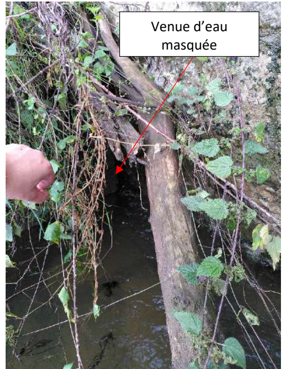
Photos 51 et 52 : Venues d'eau sur l'extrémité aval de la risberme – Ganil (BIEF).
