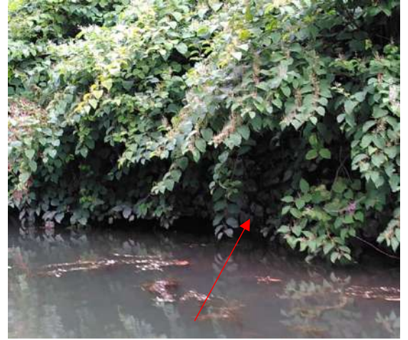
Photo 10 : Vue du perré maçonné dans une trouée dans la végétation- Ganil (BIEF).
