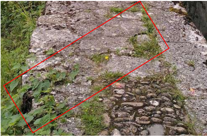
Photos 42 et 43 : Fracture et décollement au niveau de la crête de l'ouvrage – Ganil (BIEF).
