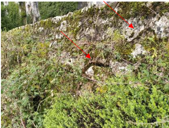
Photos 47 et 48 : Fracture et décollement au niveau de la crête de l'ouvrage – Ganil (BIEF).
