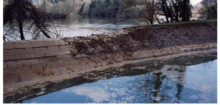
Photos 26 et 27 : Comparaison de l'état du guideau – 2021 / 1990 (BIEF).
