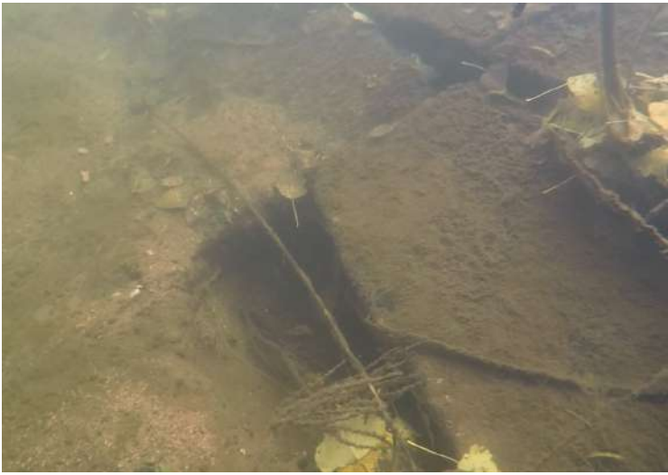
Photos 37 et 38 : Zone avec déchirage de la bâche et aspiration à la jonction – Ganil (TRAQ).
