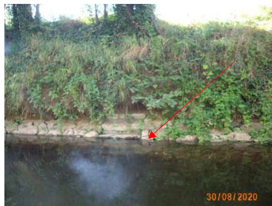
Photo 8 : Vue de la pointe amont du guideau en 1990 - Ganil (Archive MOA).
