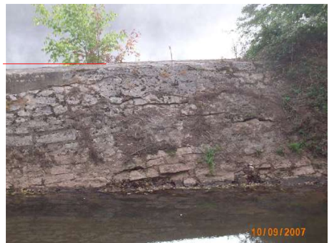
Photo 23 : Défaut d'horizontalité de la crête du guideau – (BIEF).
