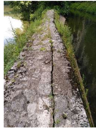
Photos 42 et 43 : Fracture et décollement au niveau de la crête de l'ouvrage – Ganil (BIEF).
