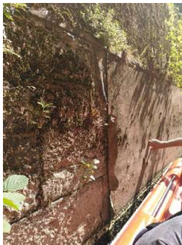
Photo 30 : Extrémité aval de la bache – Ganil (BIEF).
