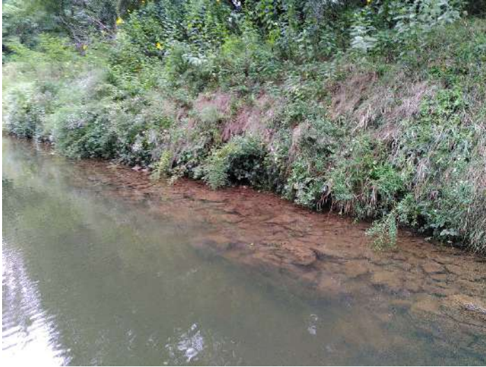
Photo 9 : Vue des risbermes maçonnées délimitant le chenal - Ganil (BIEF).
