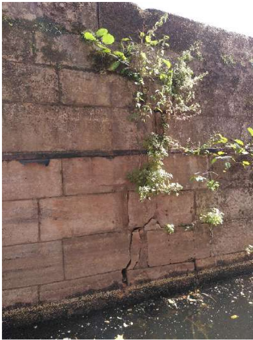
Photos 31 et 32 : Fracture au niveau du quai maçonné –Ganil (BIEF).
