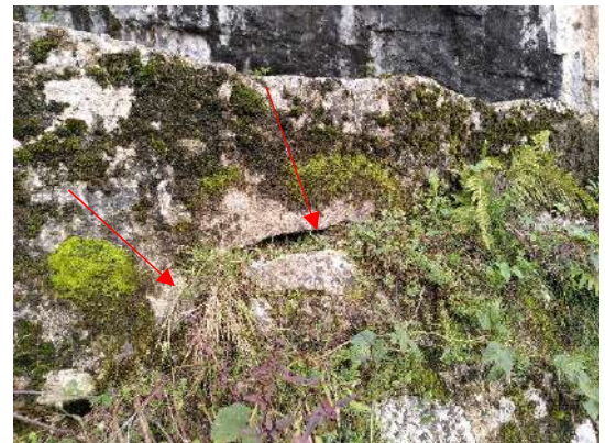
Photos 47 et 48 : Fracture et décollement au niveau de la crête de l'ouvrage – Ganil (BIEF).
