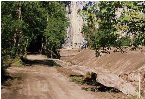
Photo 11 : Vue des travaux de reprofilage en 1990 - Ganil (Archive MOA).
