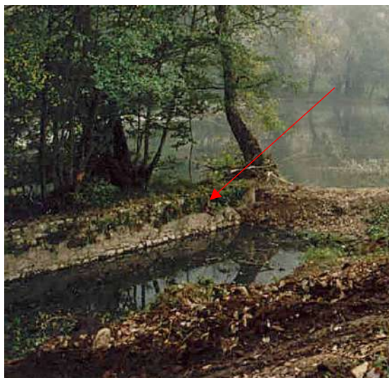
Photo 5 : Vue de la pointe amont du guideau en 1990 - Ganil (Archive MOA).
