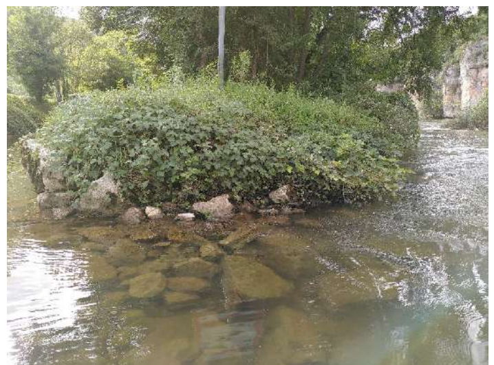
Photo 2 : Vue des blocs de la pointe amont - Ganil (BIEF).
