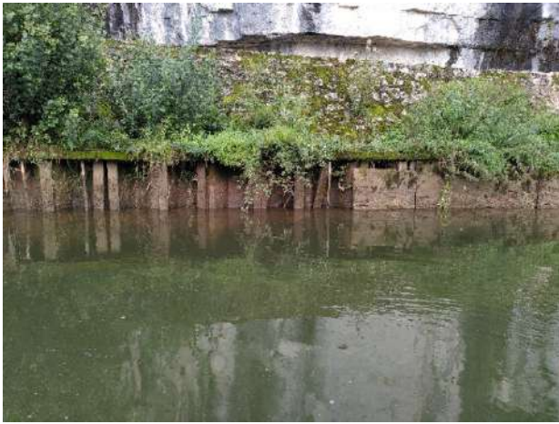
Photos 20 et 21 : Vues de la risberme côté Lot – plaques béton et palplanches – Ganil (BIEF).
