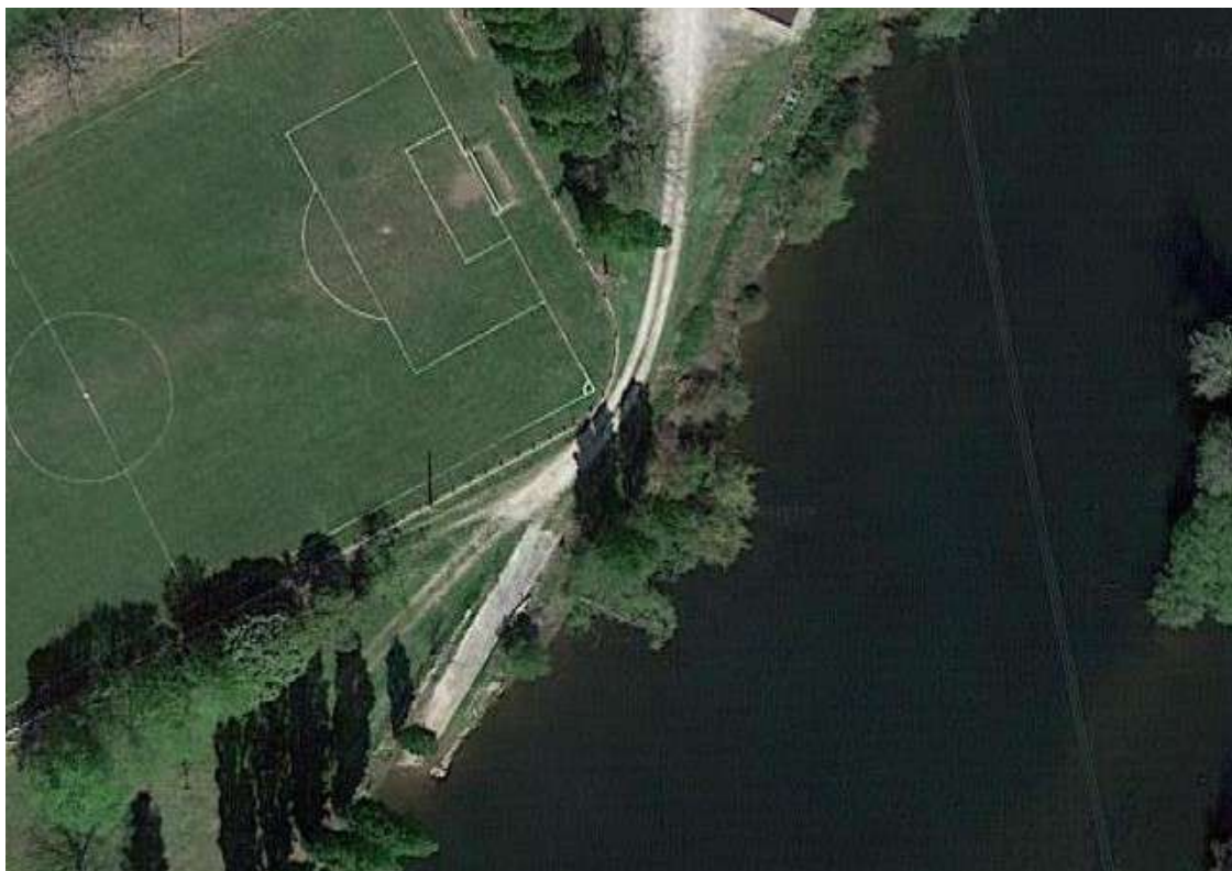
Figure 17 : Vue aérienne de la mise à l'eau de Saint-Cirq-Lapopie.
