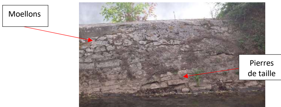
Photo 13 : Vue du perré avant mise en place de la bache - Ganil (Archive MOA).
