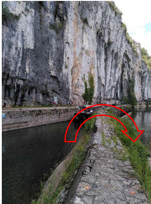
Photo 23 : Défaut d'horizontalité de la crête du guideau – (BIEF).
