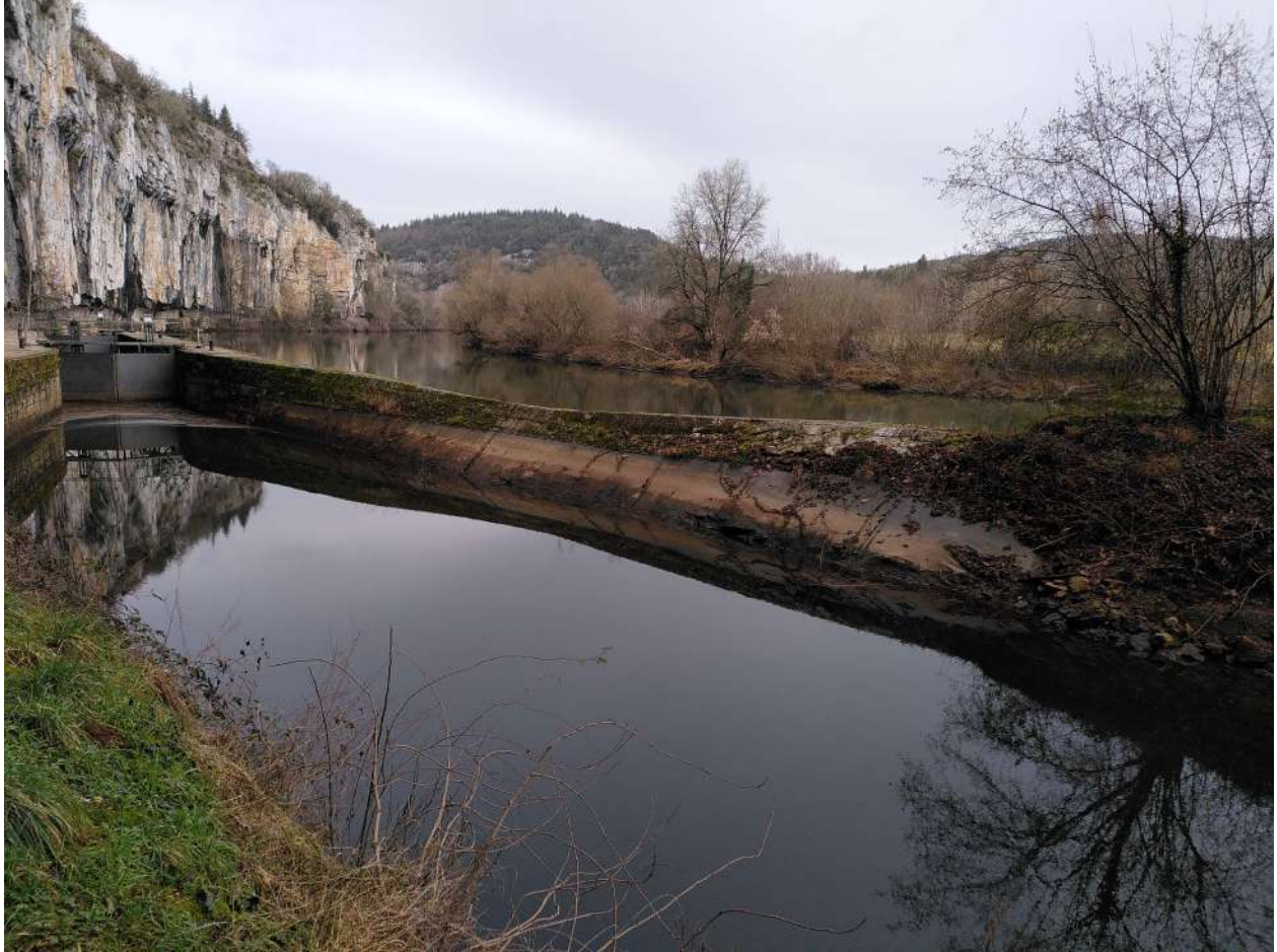
Photo 66 : Vue générale sur l'absence de végétation côté canal, le 1 er février 2022.
