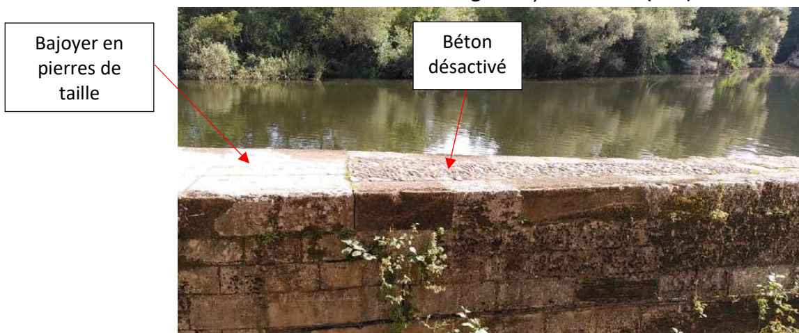
Photo 17 : Crête de la digue à la connexion avec le bajoyer - Ganil (BIEF).
