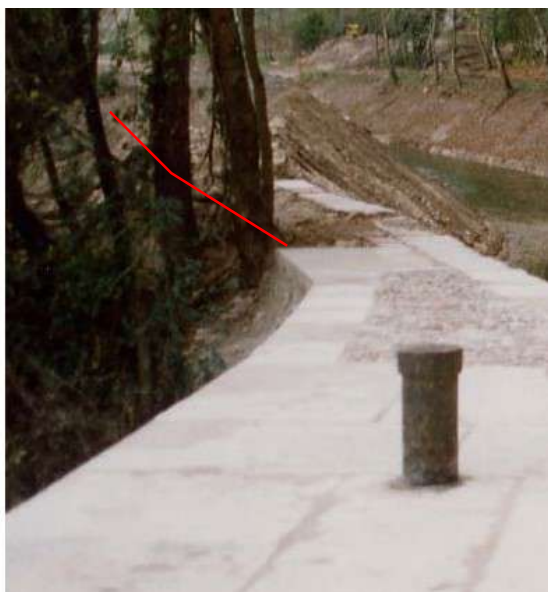
Photos 61 et 62 : illustration de la perte d'horizontalité déjà observée durant les travaux de rénovation des années 1990 (Archives MOA).
