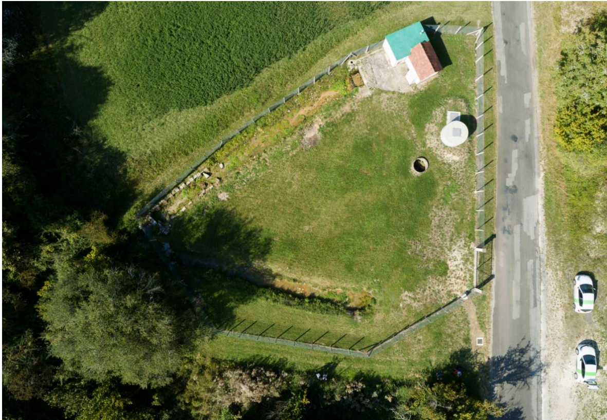
Figure 48 : Vue de la partie clôturée du PPI du captage de Bezet
