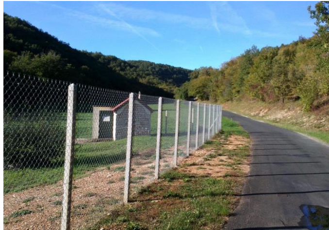
PPRI avant travaux de la bache
