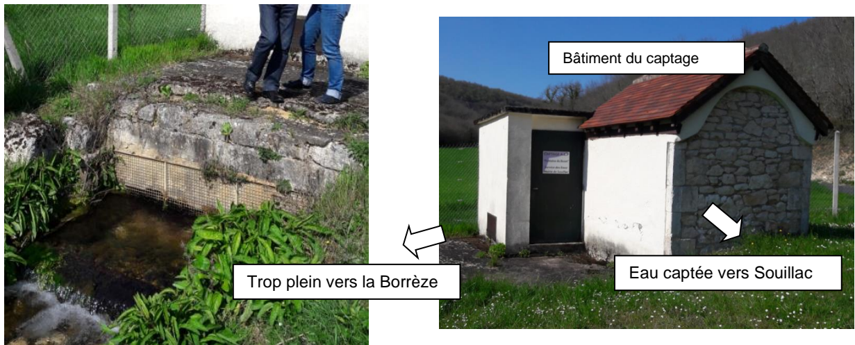
Figure 18 : Fontaine de Bezet - Vue extérieure
