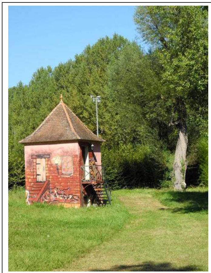
Figure 4 : vue générale du puits de captage de Pradines
