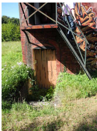
Figure 6 : Accès au puits par la porte basse
