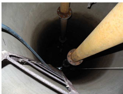
Figure 5 : Puits de Pradines ou puits de l'Ile
