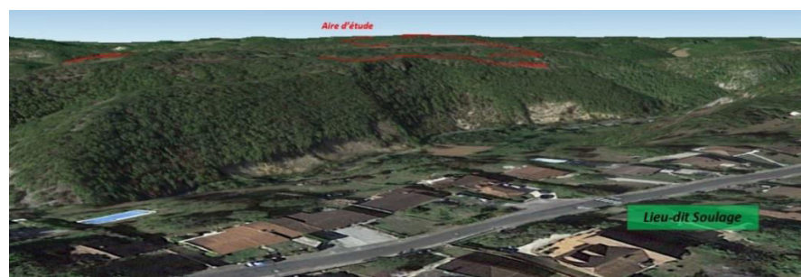
Vue aérienne vers l'aire d'étude depuis le haut de la rue Le Soulage - Source : google earth – Luxel 2017
