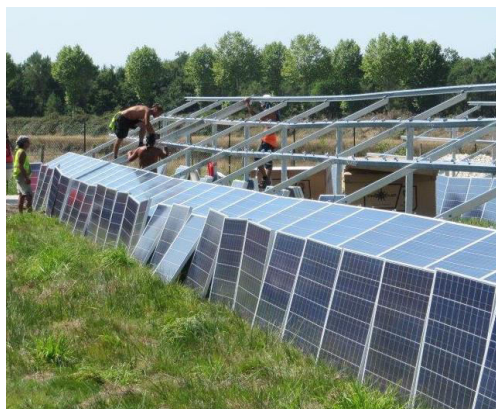
Pose manuelle des modules - Source : Luxel
