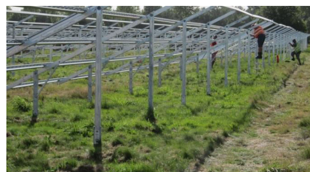
Un faible impact sur le sol et le couvert végétal lors de l'ancrage des pieux et pose de structures (Parc de Saint-Aubin de Blaye) – Source : Luxel, 2013
