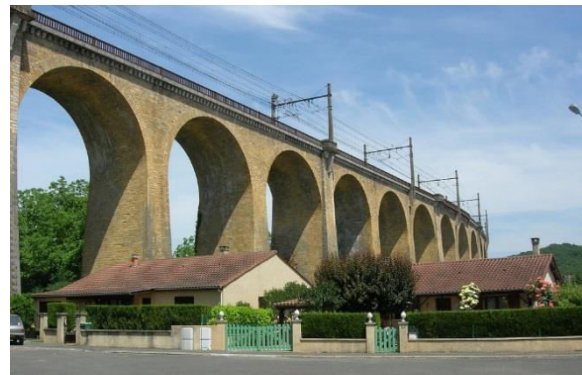
Viaduc de la Borrèze
