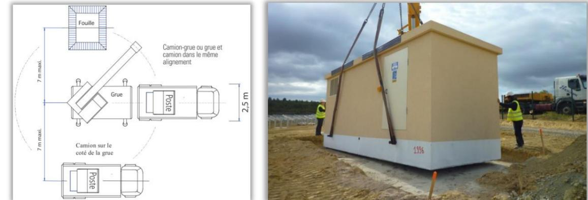
**Schéma de dépose des postes préfabriqués - Source : Transfix**
