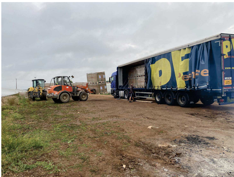
Déchargement des modules – source EnergieKontor
