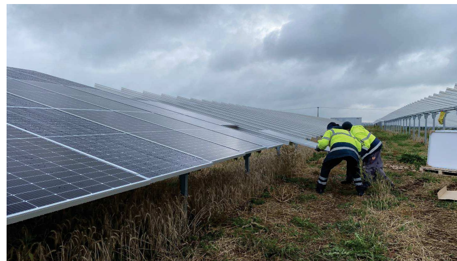
Mise en place des modules sur les structures – source EnergieKontor
