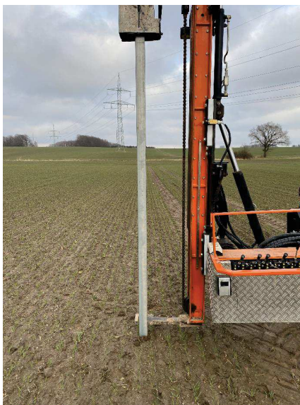
Battage des pieux – source EnergieKontor
