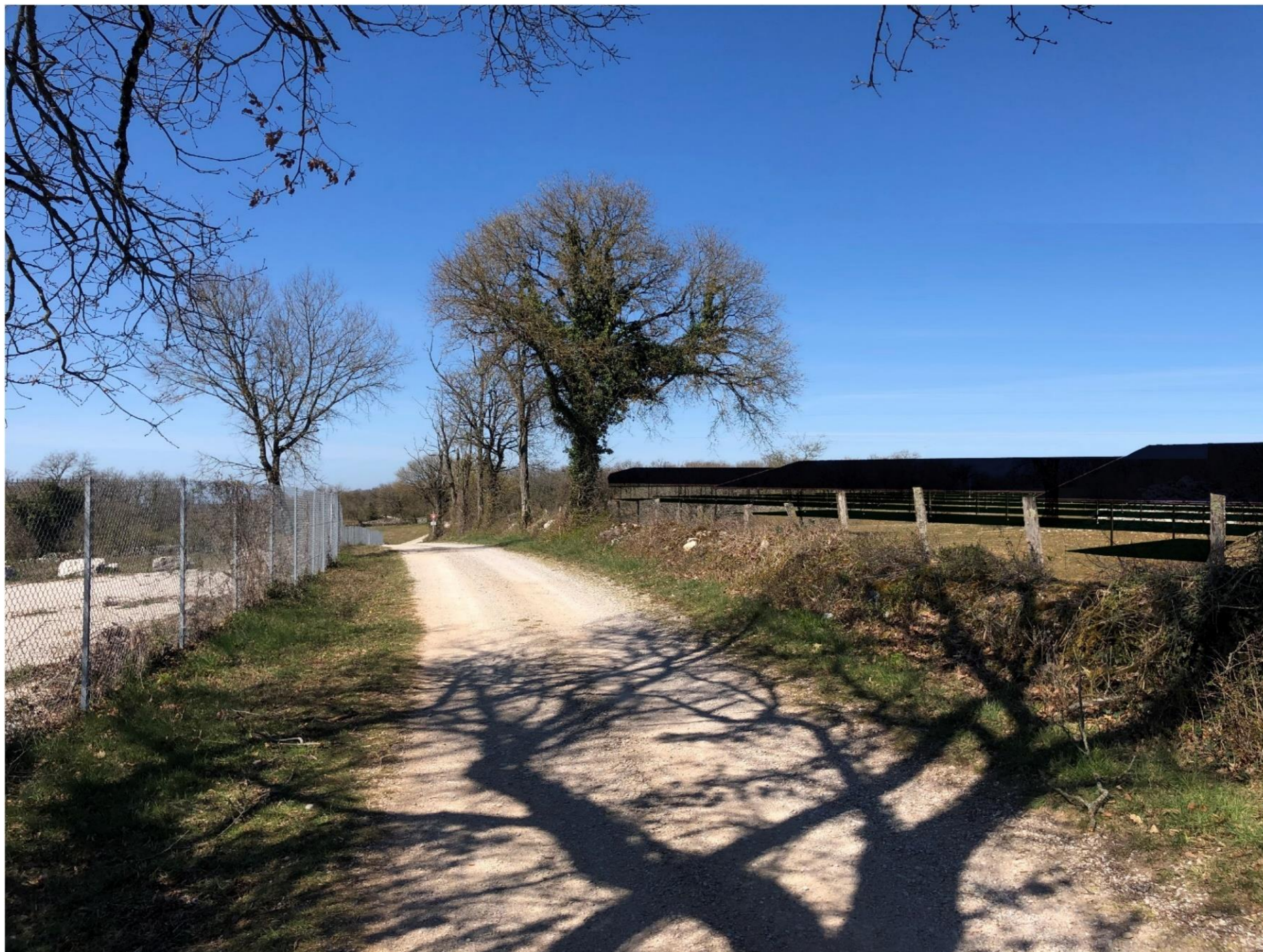
Figure 159 : Projet sans mesure d'évitement ni traitement paysager (février 2021)
