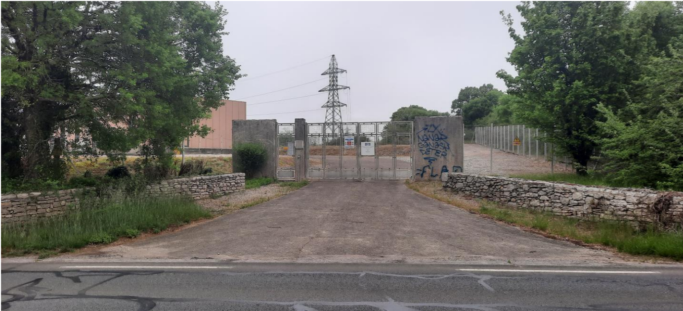
Figure 162 : Poste HTA de Rignac
