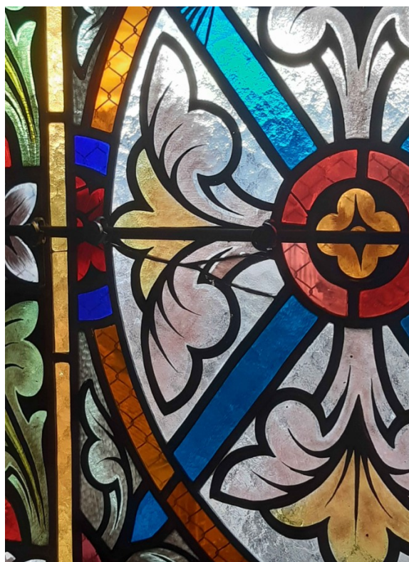
4. Illustration: CAHORS, Église Saint-Barthélémy, restauration d'un vitrail par ruban de cuivre
