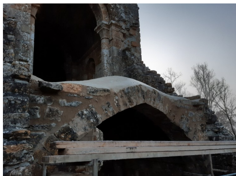
2. Illustration: CAMBOULIT, ancienne chapelle, reprise du glacis sur extrados
