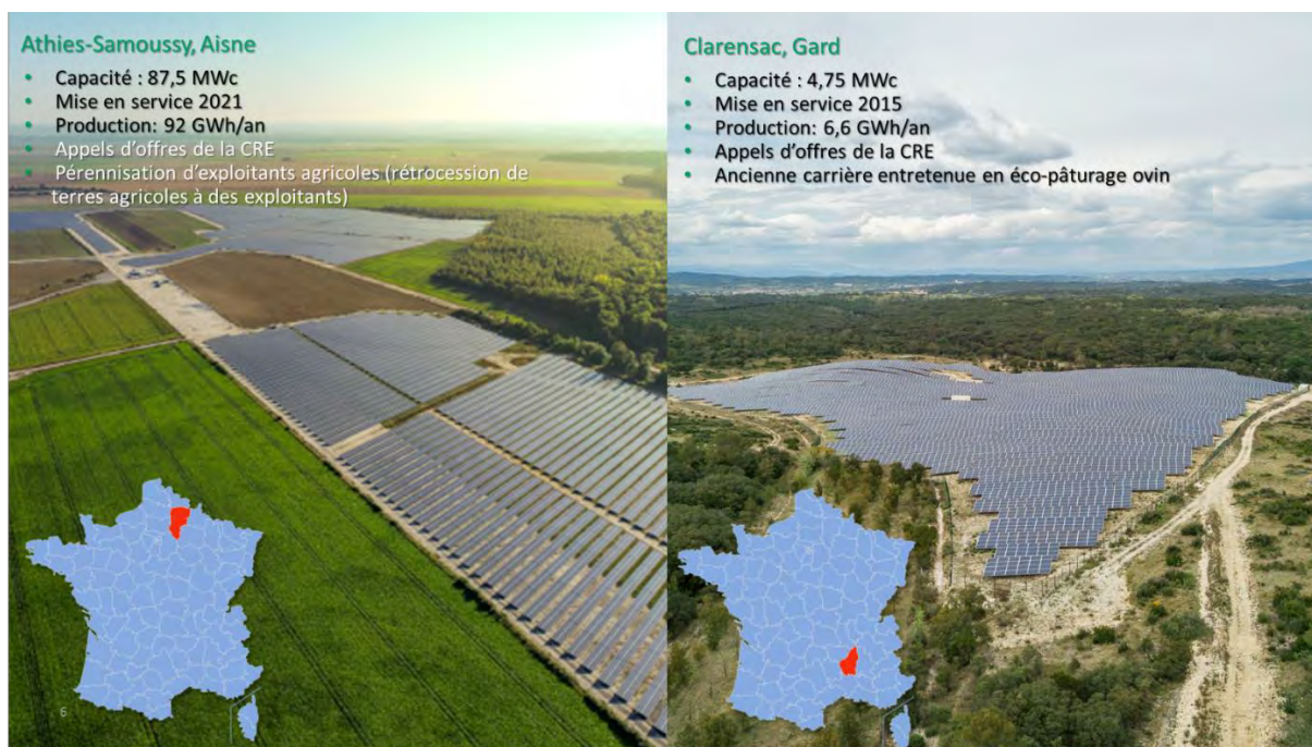
Figure 1 : Quelques exemples de centrales photovoltaïques réalisées par Plénitude en France (source : Plénitude)
