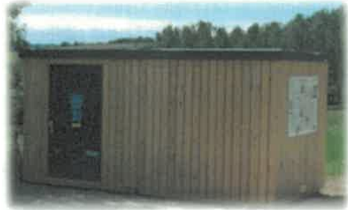
Pose de postes HTA, source : EVEO Watts 15
