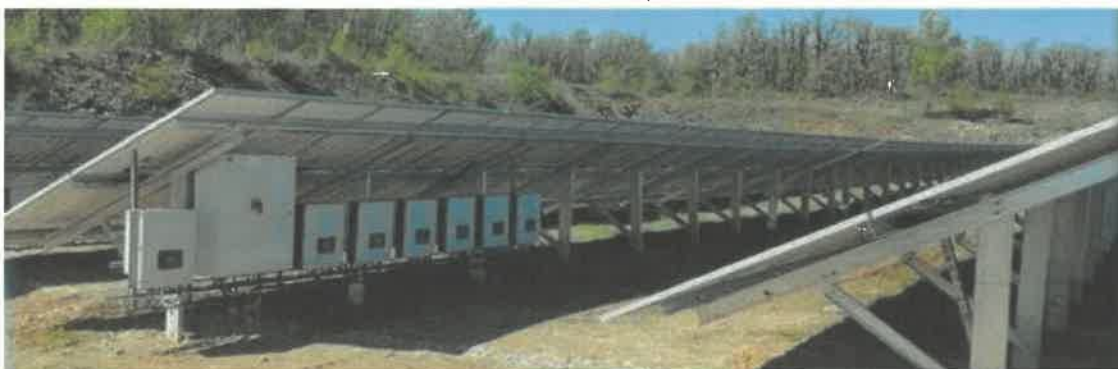
Principe des onduleurs décentralisés, source : EVEO Watts 15
