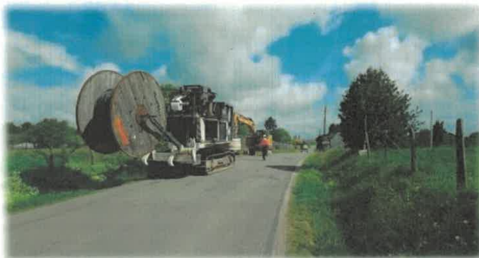
Exemple de chantier d'enfouissement de câble le long d'une voirie (source : EVEO Watts15)
