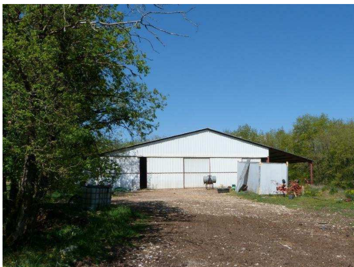
Photo 11 : Vue de la bergerie au Nord-Est du Site (RC – SD 2020 ©)
