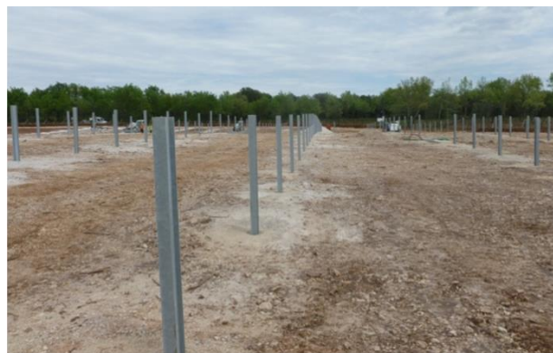
Photo 7 : Exemple de réalisation de pieux battus
