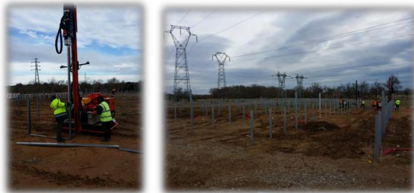
Figure 182: Mise en place des pieux battus
