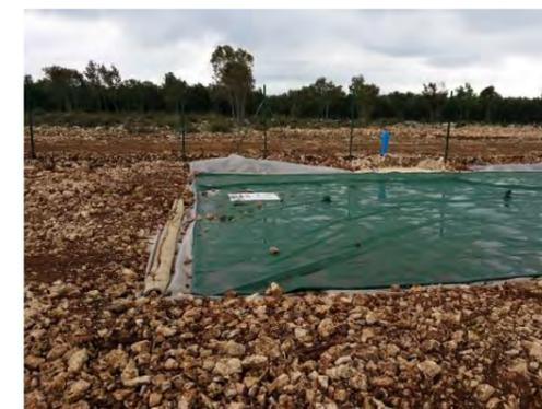
Figure 188: Illustration d'une citerne souple avant remplissage
