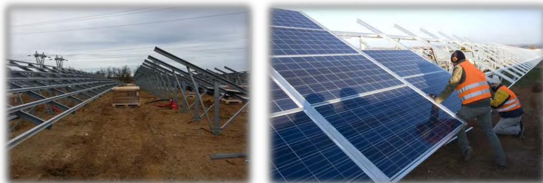
Figure 183: Montage des structures et pose des panneaux
