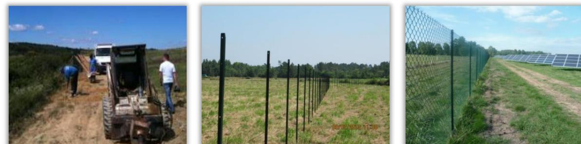
Mise en place de la clôture : pose des ancrages, des piquets et du maillage – Source : LUXEL 2010-2011-2013
