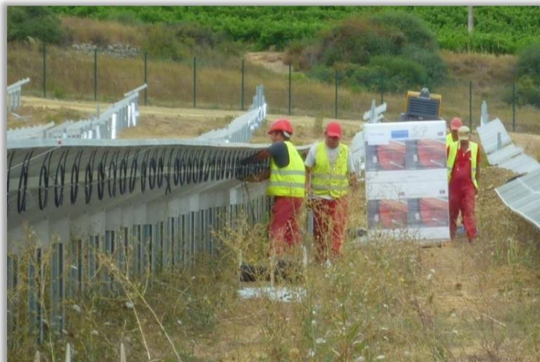
Câblage et interconnexion des modules photovoltaïques
