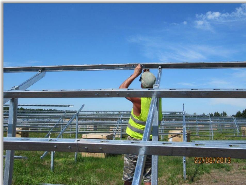
**Systèmes de fixation pour installation photovoltaïque**
