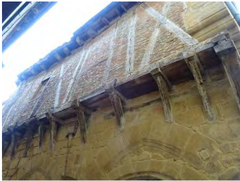
Rue du Majou. Pan de bois en encorbellement et hourdis de briques.
