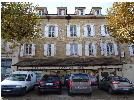
51, boulevard Antoine Mainiol, 19 e siècle. Façade moellonnée.
