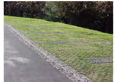
Aire de stationnement stabilisée en milieu naturel.
