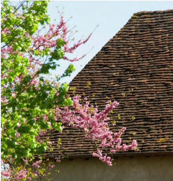
Couverture de tuiles plates
