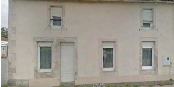
Une maison de pierre et d'enduit, avec ses encadrements de baies en pierre massive taillée.
