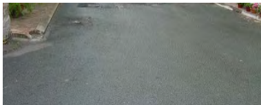
Sol « routier » en enrobé...dans l'attente d'un sol mieux adapté à l'architecture du village, à terme.
