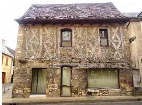
41, avenue Cavaignac. Pan de bois (du 15 e siècle ?) remonté au 18 e siècle en retrait du plan du rez-de-chaussée.
