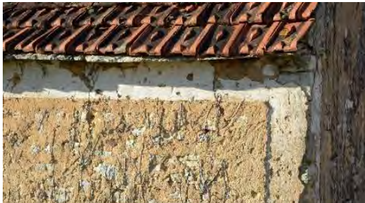
Maillol. Grange. Enduit de sable de carrière ocré et de chaux. Un bandeau fait d'un enduit taloché et recouvert d'un lait de chaux blanc souligne l'angle et l'arase du mur.
