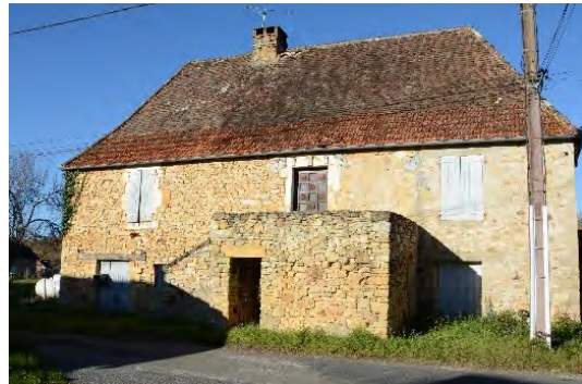
La Fontade Maison rurale à travées avec escalier extérieur
