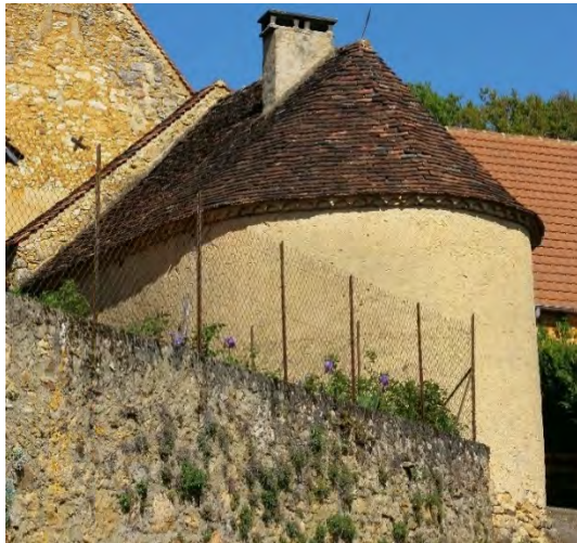
Prouhliac. Cul-de-four en maçonnerie de moellons enduite.
