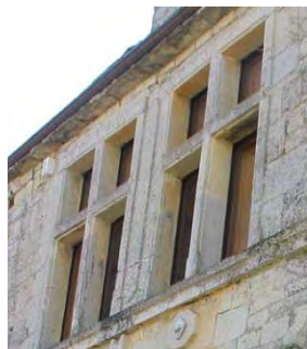
Repaire de Costeraste, Fenêtres à meneau et volets intérieurs.
