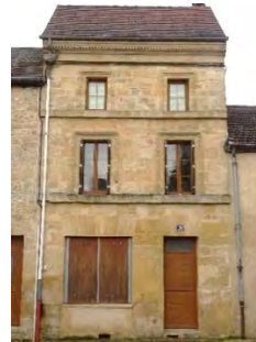
76, avenue Gambetta. 19 e siècle. Façade en pierre de taille et modénature.
