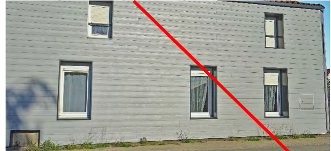
La même maison, après isolation par l'extérieur.
