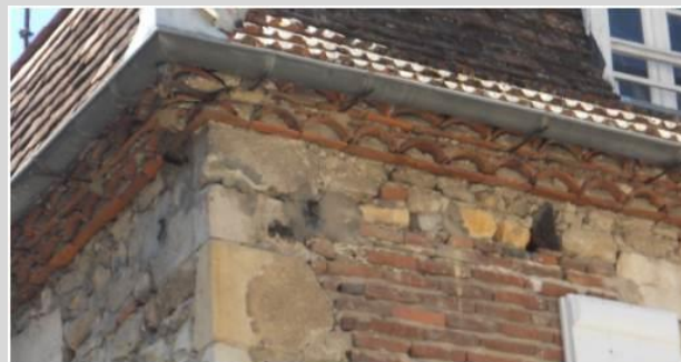
Exemple de toits à combles brisés soulignés d'une génoise. A noter que, dans le premier exemple les abouts de solives destinés à supporter les chevrons en débord ont été sectionnés pour permettre la mise en œuvre d'une génoise.
