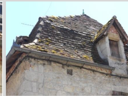
Exemple de toits à combles brisés soulignés d'une génoise. A noter que, dans le premier exemple les abouts de solives destinés à supporter les chevrons en débord ont été sectionnés pour permettre la mise en œuvre d'une génoise.
