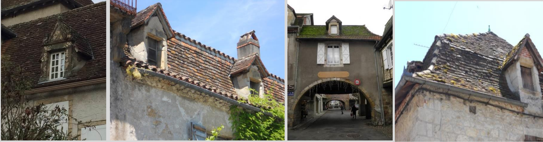
Exemples de lucarnes en pierre à fronton. A noter le premier exemple particulièrement remarquable de lucarne à fronton mouluré du XVIIème siècle. Dans le dernier exemple, la lucarne est dite passante car elle interrompt l'égout de la toiture.
