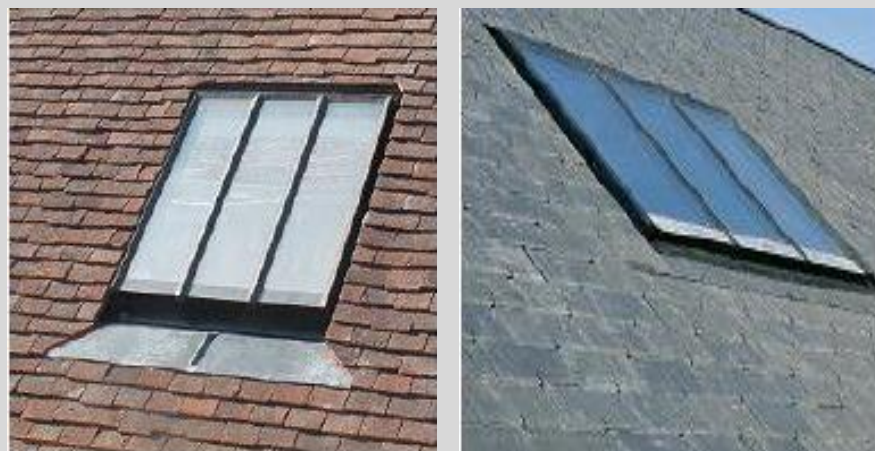
Exemple de châssis de toiture en fonte recoupés par un ou deux meneaux
