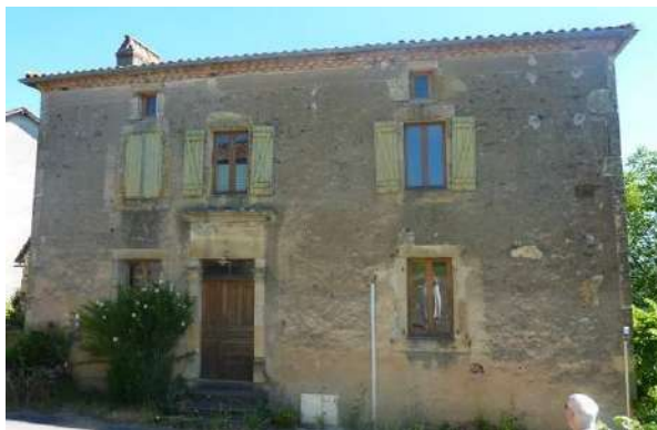
Ladirat : maison à travée avec porte piétonne ornée d'un entablement et de pilastres (18 e siècle ?).
