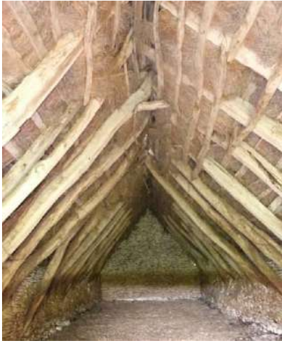
Le Bastit, Le Mège : époque moderne avec une charpente à arbalétriers courbes et isolation végétale.
