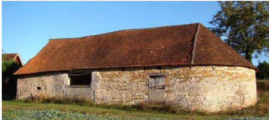
Floirac, la Martinie Sud : grange absidiale qui pourrait dater du 17 e siècle. Sa charpente est assemblée plus tardivement.
