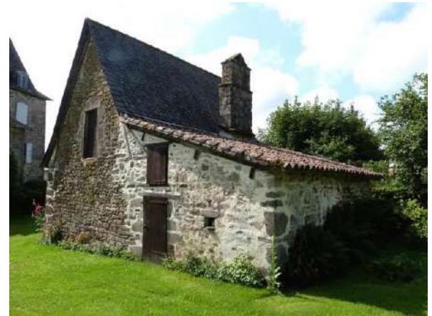
Soue et séchoir accolés au fournil (Sousceyrac-en-Q.).
