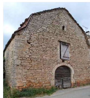
Toiture à fortes pentes remplacée par un toit à la Mansart (Beauregard).
