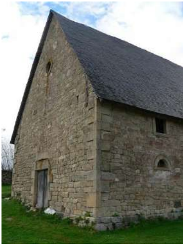
Toit à fortes pentes (Sénaillac-Latronquière).
