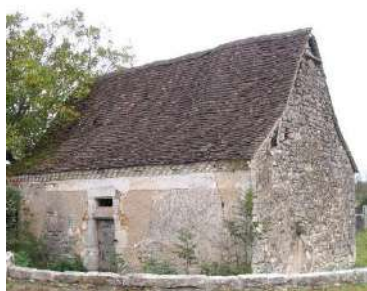
Toiture à fortes pentes (Durbans).
