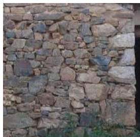
Maçonnerie de gneiss et de granite (Prendeignes).
