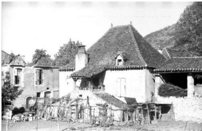
Toit à fortes pentes (Castelfranc).
