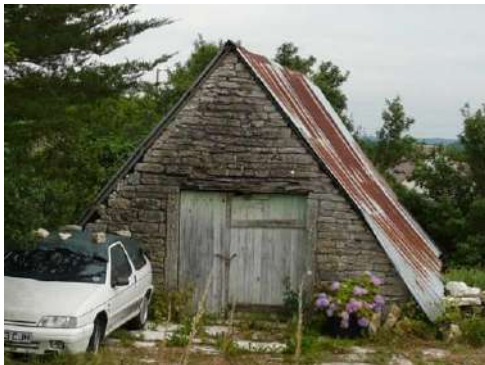
Sénailac-Lauzès : grange avec charpente posée au sol (18 e siècle ?).
