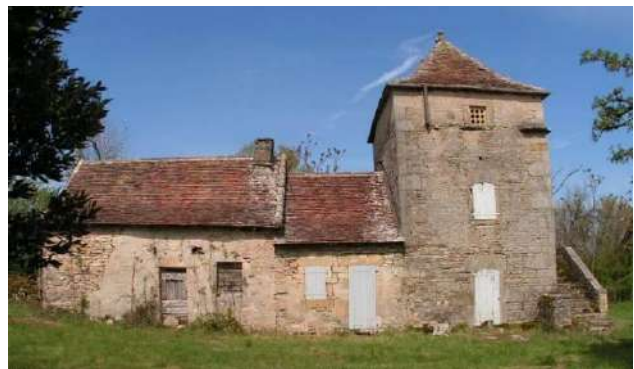
Saillac : deux logis en rez-de-chaussée accolés à une tour-pigeonnier.
