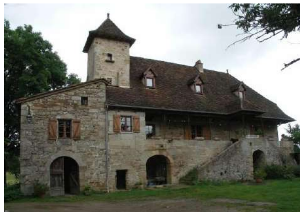
Figeac, Trémont : logis du 17 e siècle avec galerie couverte et escalier à deux volées.
