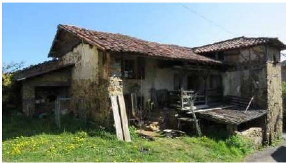
Predeignes : ajout d'un corps perpendiculaire en pan de bois.
