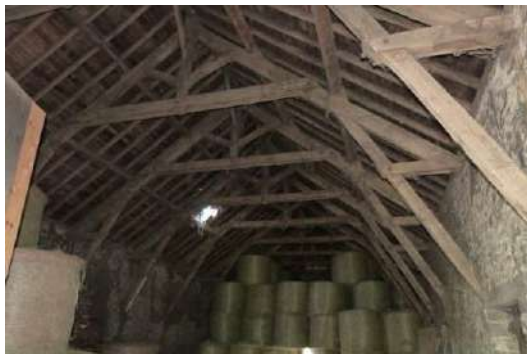
Charpente à ferme à entrails retroussés et poinçons de 1950 (Sousceyrac-en-Q., Proupech).
