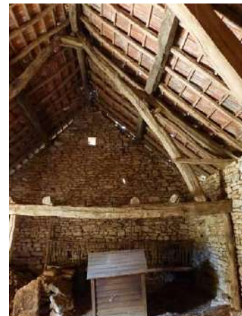
Cuzance, Ferran : grange-étable à travées (16-17 e siècle) dotée d'une charpente à arbalétriers courbes. L'un des deux arbalétriers repose sur un entrait servant de solive de plancher pour le fenil.
