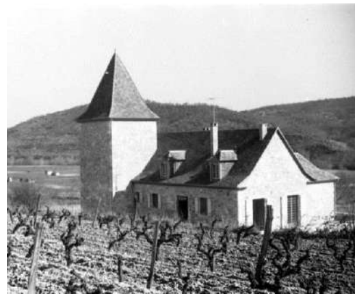
Toit à fortes pentes (Albas).
