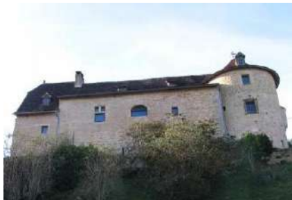
Loubressac, Miramont : manoir 15 e -16 e siècle sur des bases médiévales.
