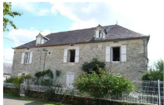
Cuzance, le Mas Haut : maison de maître construite en 1909.
