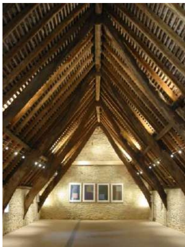
Saint-Médard-Catus, Rouergoux : 16 e siècle avec une charpente à arbalétriers courbes.
