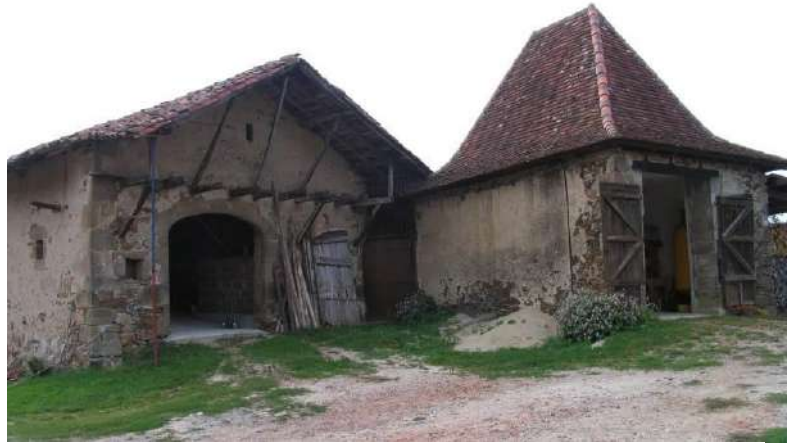
Toit à fortes pentes (Prendeignes, Lasfargues).
