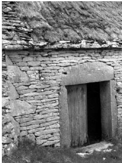
Lauzes calcaires en rives et égouts de toit (Blars).
