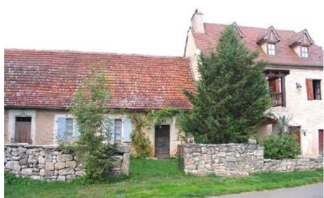
Durbans, Le Cornouillé : série de trois maisons ou logis triple du 16 e siècle dont deux en rez-de- chaussée et une troisième surélevée postérieurement.
