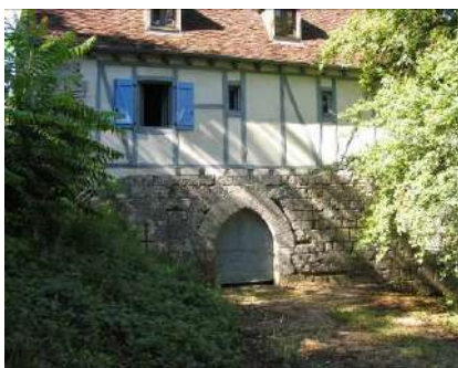
Meyronne, moulin de Limon : base médiévale et étage postérieur en pan de bois.
