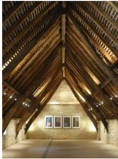
Charpente à arbalétriers courbes datée de 1537 (St-Médard-Catus, Rouergoux).
