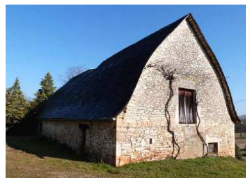
Toiture à la Philibert Delorme (Mayrac).
