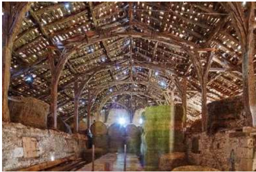
Castelnau-Montratier-Ste-Alauzie, Coupet : charpente à portiques (début 19 e siècle).
