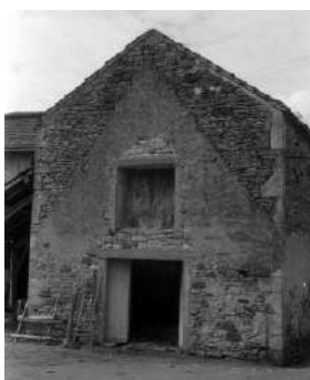
Toiture à fortes pentes remplacée par des faibles pentes (Saint-Caprais).
