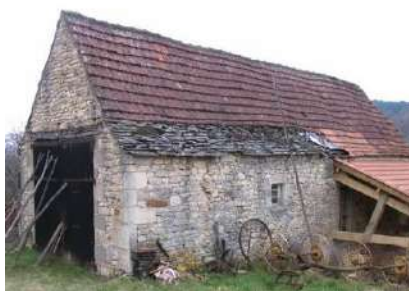
Toiture à fortes pentes (Praysac).
