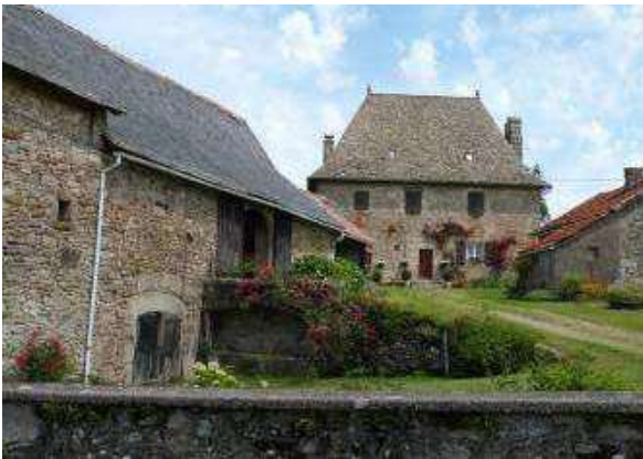
Sousceyrac-en-Q. (ex-Comiac), Mezayrac : ferme à éléments distincts sur cour.
