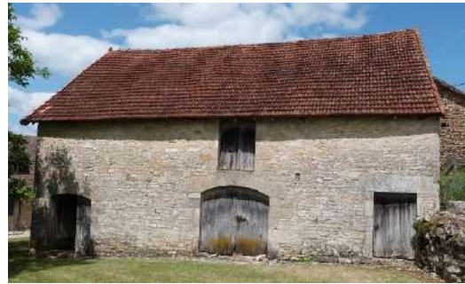
Cuzance, Le Bournissard : grange-étable à travée dite limousine, reconstruite à la fin 19 e ou début du 20 e siècle.
