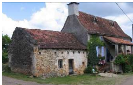
Toiture à fortes pentes (Laramière).
