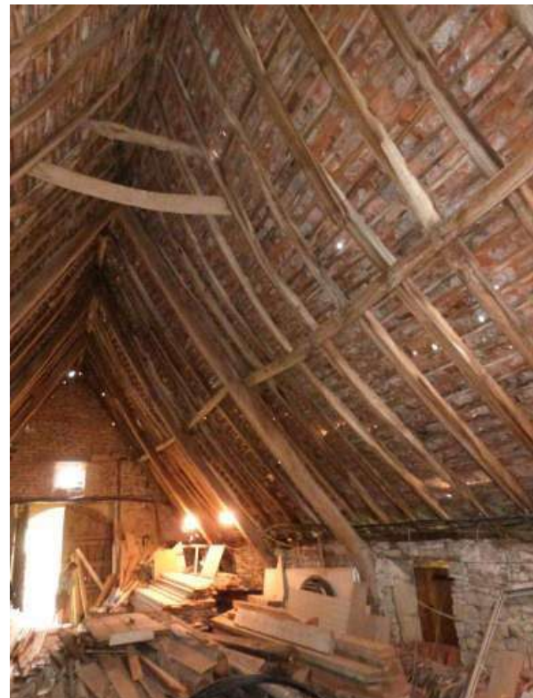
Charpente à arbalétriers courbes (Lunan, la Contie).
