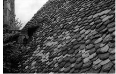
Lauze de schiste taillée en écaille (Saignes).
