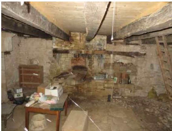
Salle commune couverte d'un dallage en pierre (Pontcirq, Garric Blanc).
