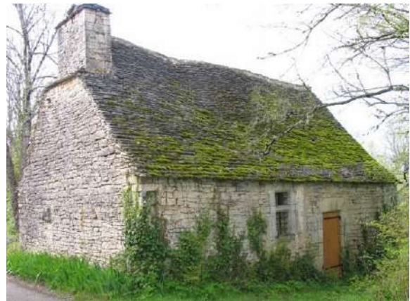
Pontcirq, Garric Blanc : maison datée de 1604 et dotée d'une demi-croisée.
