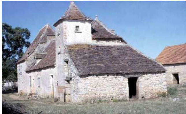
Carluçet, Sol del Puech : logis agrandi en partie au 19 e siècle.
