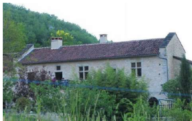
St-Jean-Lespinasse, Tourel : logis double du 15 e siècle.
