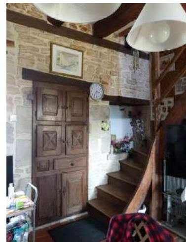
Cuzance, Lagarrigue : même maison, la seconde porte piétonne a été transformée en placard.
