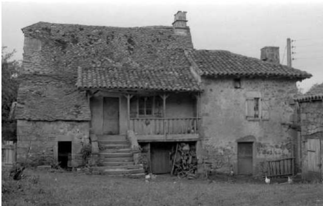
Toit à fortes pentes (Terrou).
