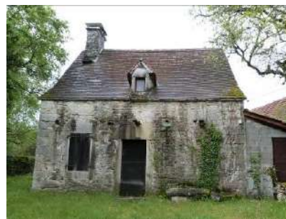
Toitures à fortes pentes (Varaire).
