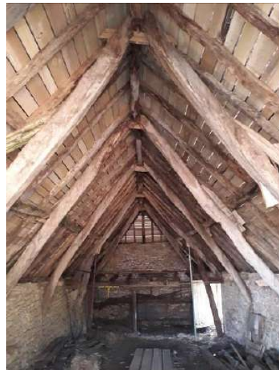
Bellefont-la-Rauze, St-Michel-de-Cours : charpente à arbalétriers courbes datée vers 1490.
