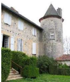
Pontcirq, la Bastidette Basse : 15 e -16 e siècle avec une tour du 17 e siècle.
