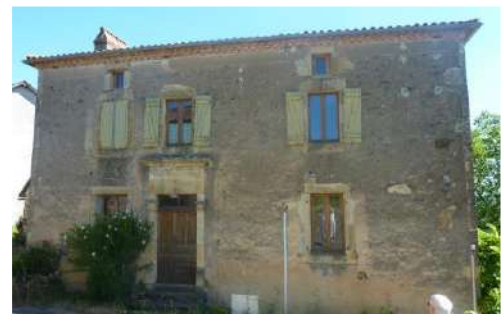
Ladirat : Maison bourgeoise du 18 e siècle avec porte piétonne ornée d'un entablement et de pilastres.
