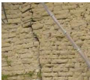
Maçonnerie en brique de terre crue (Castelnau-Montratier).
