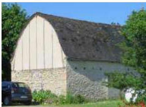
Toiture à la Philibert Delorme (Creysse).
