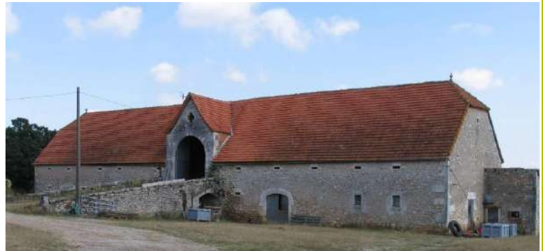
Fontanes-du-Causse : grange avec porche (19 e siècle).
