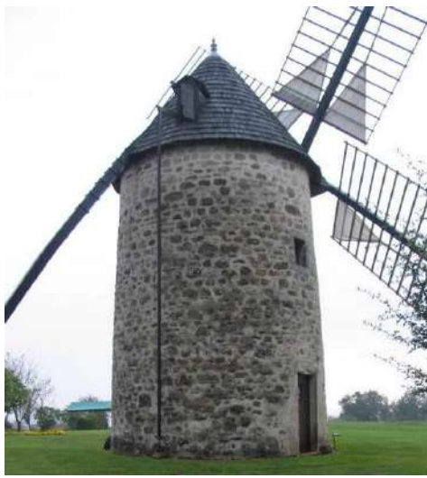
Lunan, Sérignac : moulin à vent. La porte piétonne est agrémentée d'un linteau à arc en accolade.
